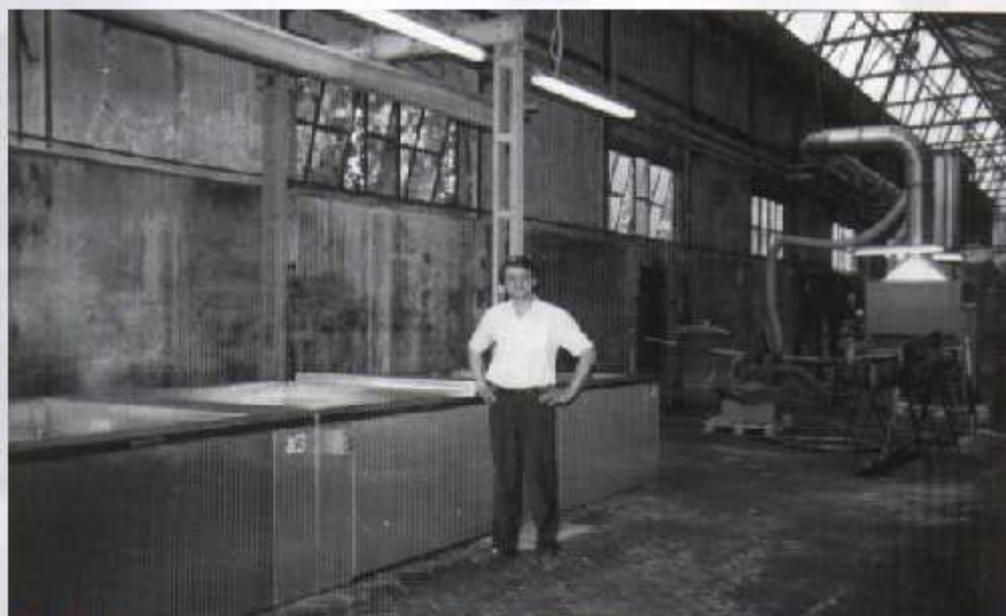
FIG. 1 - TYPICO IMPIANTO ULTRASUONI I.E. TIPO US 2000-IMSO COMPOSTO DA: LAVAGGIO CALDO CON ULTRASUONI, RISCIAQUO IDROGINETICO, PROTEZIONE CON ASCIUGATURA FINALE
